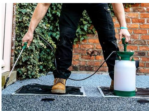
Pebble Glues'utilise pur. Verser le produit dans un pulvérisateur à pression standard et appliquer sur les graviers.
