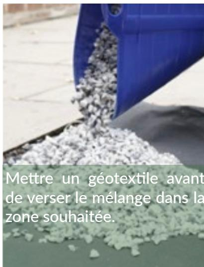
Mettre un géotextile avant de verser le mélange dans la zone souhaitée.
